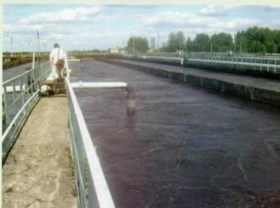
*Аэротенки. Полный процесс очистки сточных вод в аэротенке складывается из нескольких стадий: стадия – адсорбция загрязняющих веществ активным илом; биodeградация адсорбированных веществ; заключительная стадия – восстановление начальной активности ила (регенерация)*
