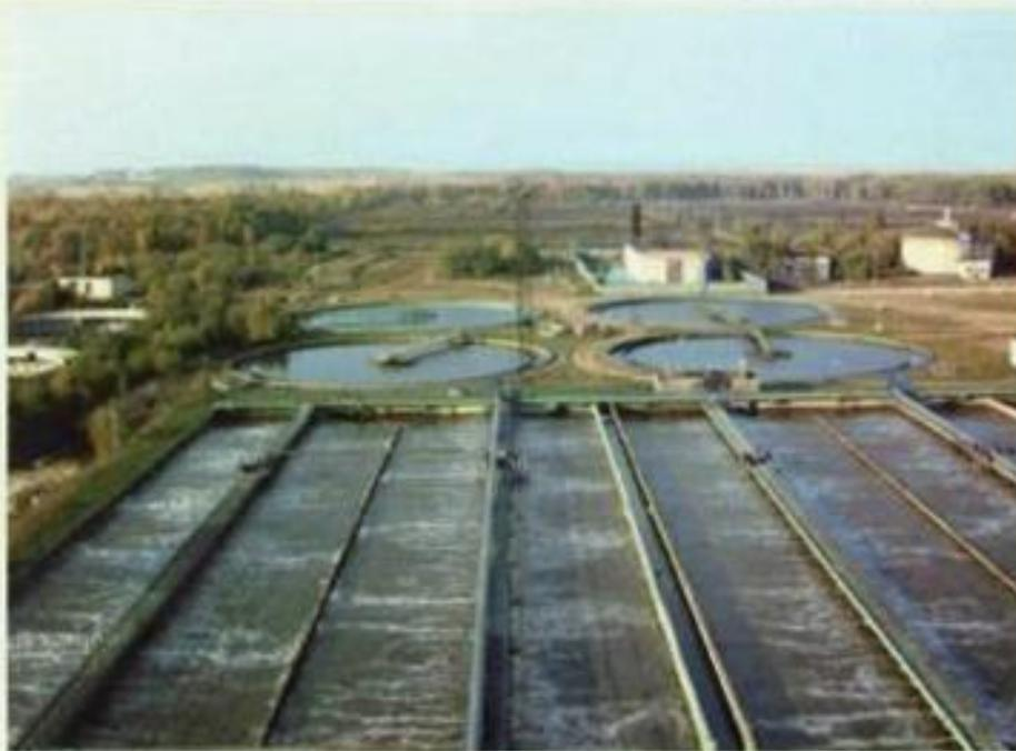
*Сооружения для механической очистки сточных вод:
